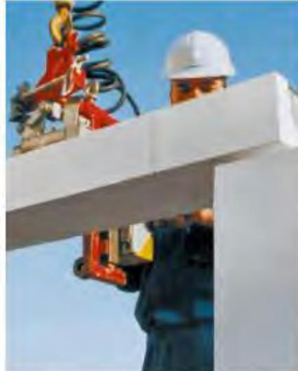
**Bild 27** Vorgefertigte KS-Flachstürze zur schnellen und rationellen Öffnungsüberdeckung
