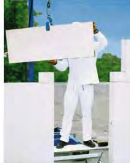
**Bild 28** KS-Fertigteilstürze für großformatiges Mauerwerk
